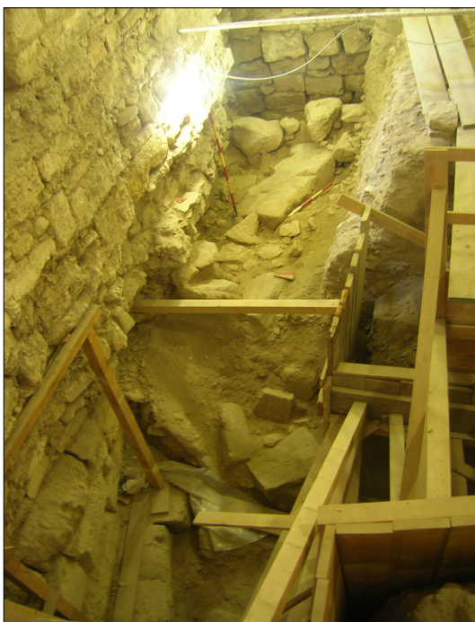
Figura 3 Castello Aragonese, ala settentrionale. Foto da ovest di parte degli strati e dei materiali costituenti il terrapieno del bastione difensivo (foto dell'Autore)
