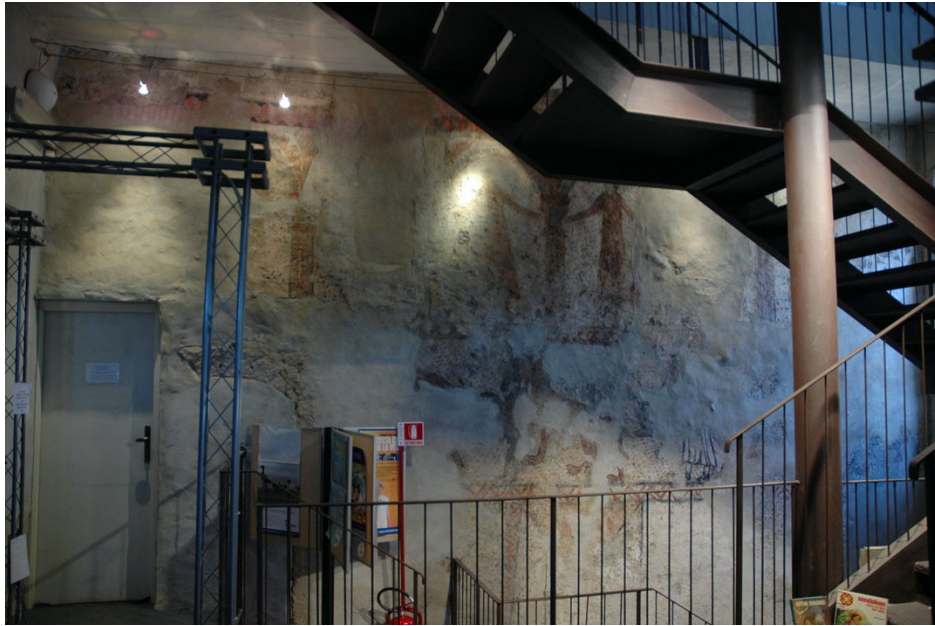
Fig. 28 – Decorazione pittorica sulla parete ovest dell'aula al primo piano, 1250 ca. Torre di Sant'Ambrogio di Torino
