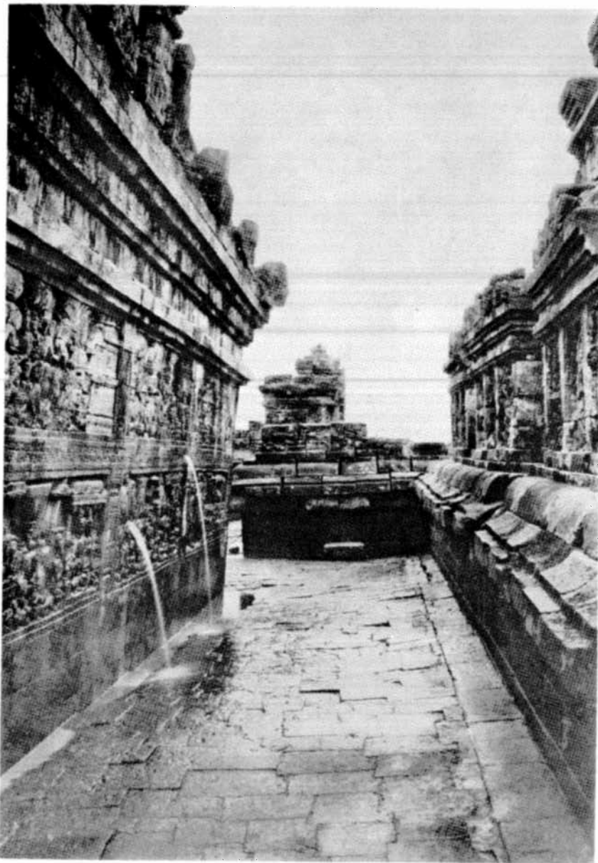
Borobudur, camminamento di una delle terrazze quadrate. L'acqua piovana riemerge tra le superfici scolpite, dopo aver completamente impregnato la collina-supporto. (da de Beaufort)
