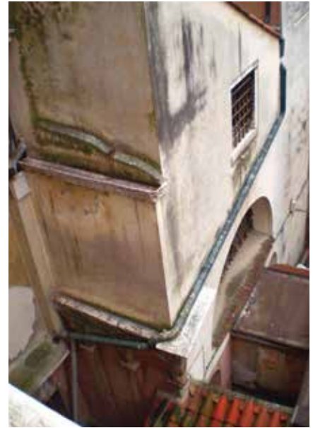
2. Venezia, Chiesa di San Bartolomeo, cappella della Madonna del Rosario, esterno. Si osservino i volumi della rifabbrica secentesca sovrapposti al corpo medioevale originario
