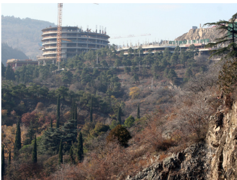
Figura 5 Il secondo edificio del progetto Panorama in corso di realizzazione nell'area collinare di Tbilisi. © Autore
