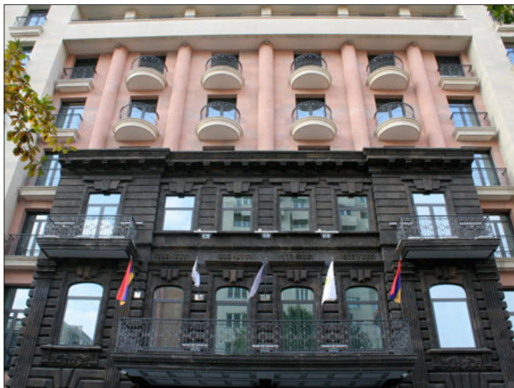
Figura 2 Facciata di un edificio storico abbattuto incorporata in una nuova struttura edilizia (Hotel The Alexander)
