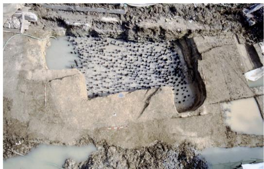
Figura 3 Palificata di sostegno di grande monumento funerario dallo scavo del Sottopasso SS 53. Archivio fotografico SABAP-VE-MET
