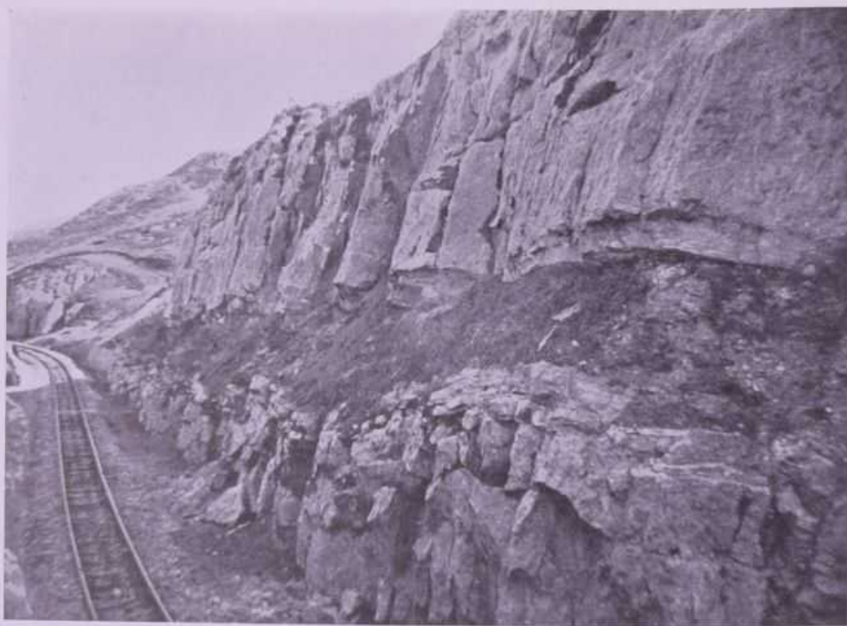
FIG. 4 - Banconi di gesso "spicchiolino", a Grottacalda, divisi dal "partimento" marnoso e con sottile base di gesso "balatino", visibile sotto il bancone superiore.
