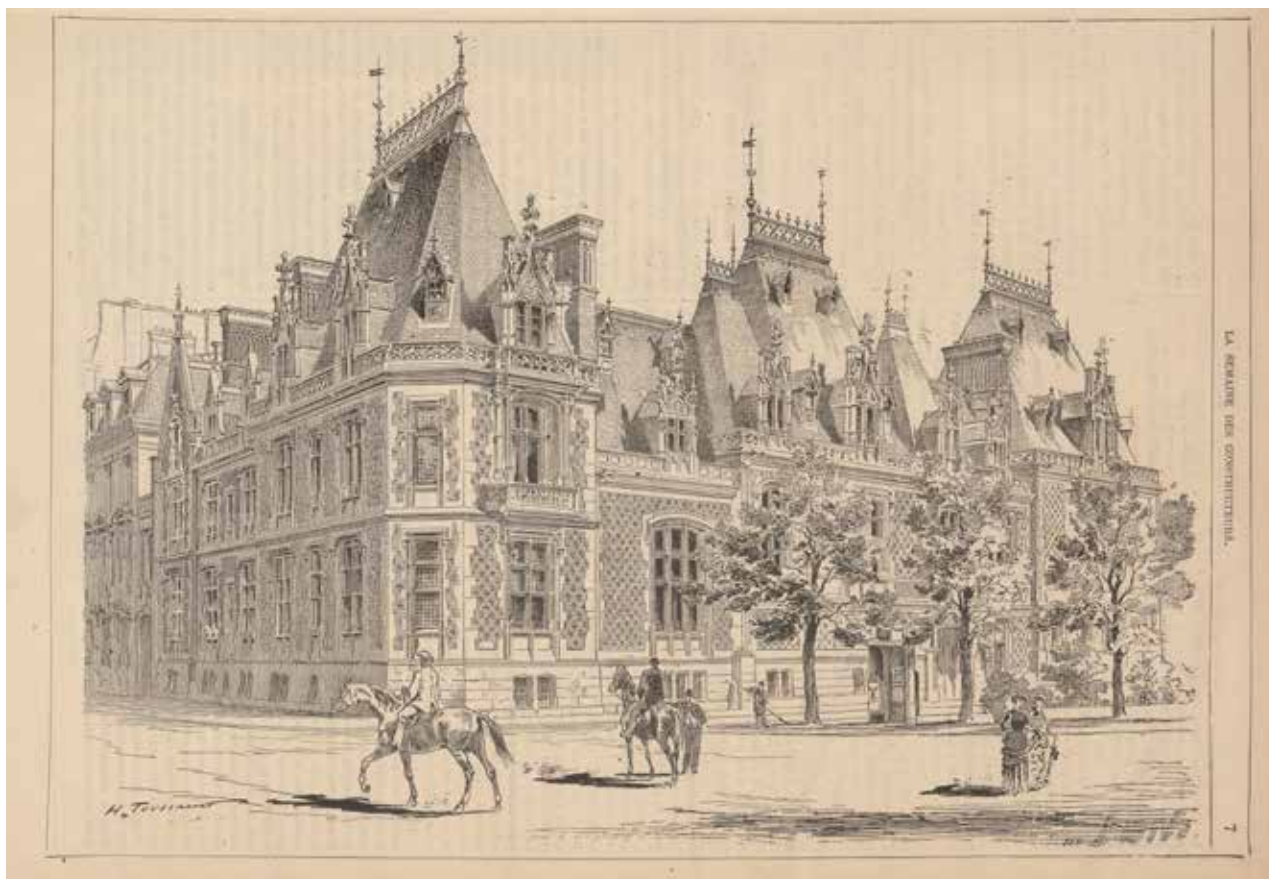
Figura 6. Jules Févier architecte, Hôtel Gaillard. 1878-1882. La Semaine des Constructeurs , VII, 1 er juillet 1882, p. 7. © BnF
