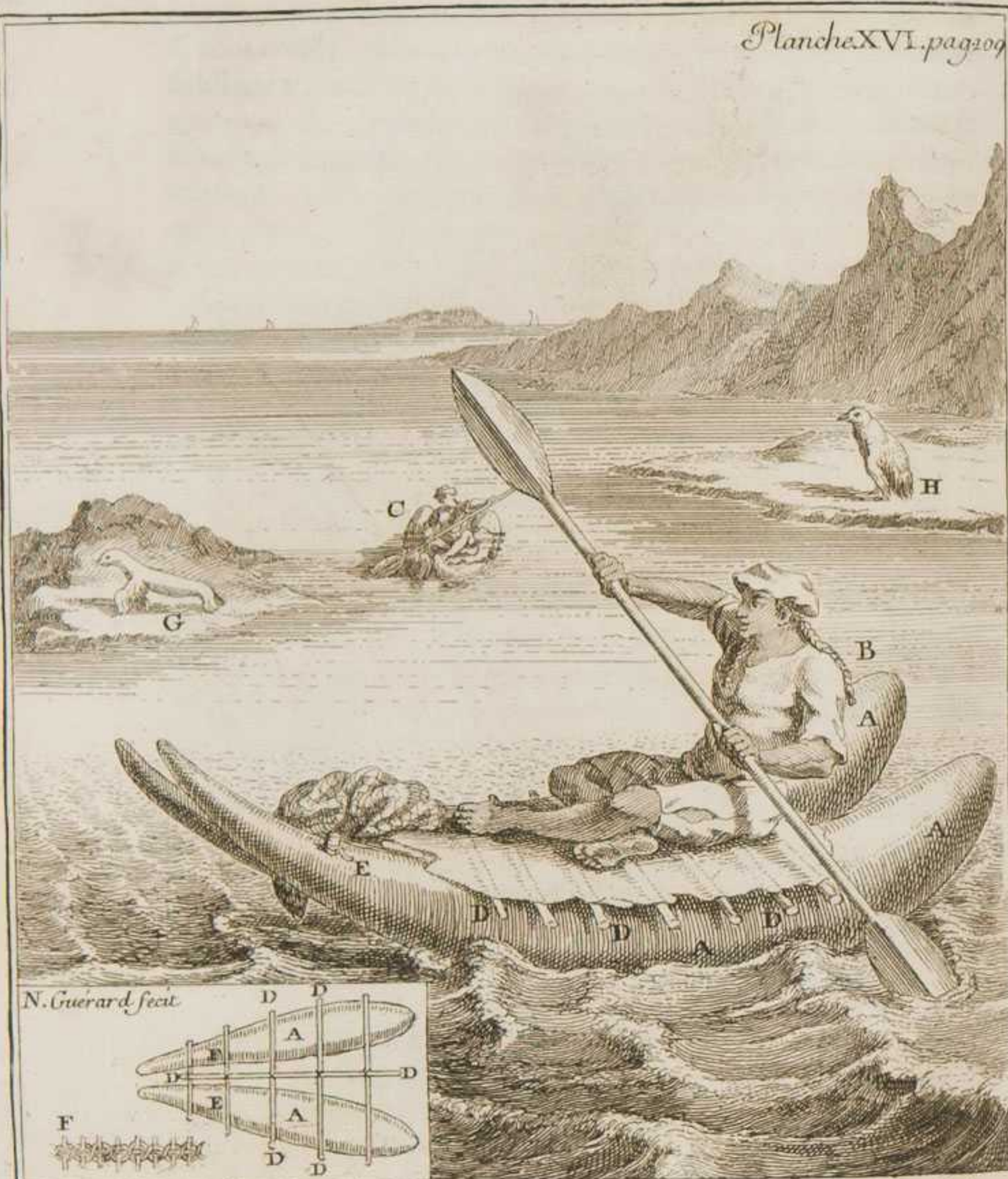
A. Plan d'une Balse faite de peaux de loups marins cousues et pleines d'air. B. Indien sur une Balse vue de Côté. C. autre vue de front D. Traverses pour rassembler les deux moitié de la balse E trou pour leinfler et la remplir d'air. F. maniere de Coudre les peaux G. Loup marin a terre H Pingoïün.
